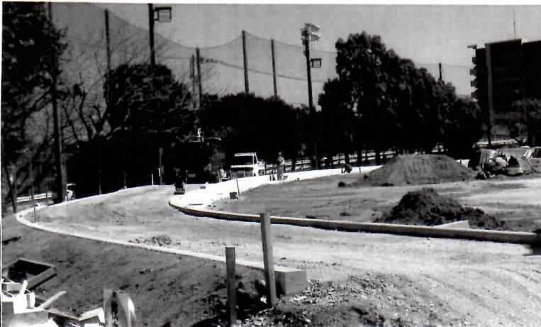
県の治水工事として、高知市商業高校の運動場工事が進み、まもなく完成します。5700㎡内かけて、上の写真のように運動場をぐるりとコンクリート壁で囲みます。そのまわりは、走行(運動・ランニングなど)で歩き面をもうけています。大雨が降れば、一旦、水は運動場面に貯水され、1つがマスから、1つ1つ排水されることになっています。
